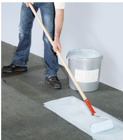
Fig. 1: precoating with alwitra primer
